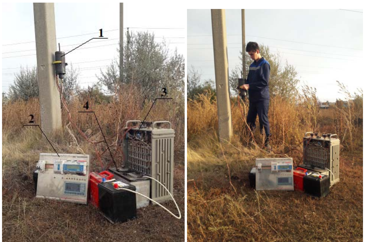
Рис.6.2 – Полевые испытания ЛЭМД-привода для погружения продольно-неустойчивых стержневых элементов в грунт: 1 – электромагнитная ударная машина; 2 – устройство управления; 3 – емкостной накопитель энергии; 4 – аккумуляторный источник питания
